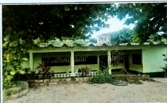
Foto 3: MODULO A Cambio de cubierta de Asbesto cemento en mal estado, se cambiara por estructura metalica y lamina troquelada cal 26. Se hara solera de corona perimetral,
