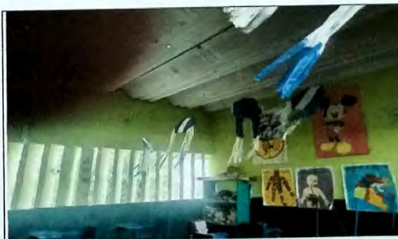
Foto 4: MODULO A Cambio de cubierta de Asbesto cemento en mal estado, se instalara estructura metalica y lamina troquelada cal 26
