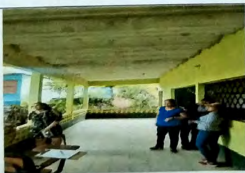
Foto 5: MODULO A Cambio de cubierta de Asbesto cemento en mal estado, se instalara estructura metalica y lamina troquelada cal 26. Se hara solera de corona perimetral
